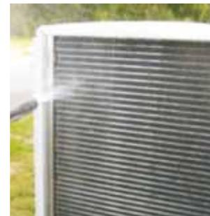
Nach der Reinigung ist der Verdampfer visuell auf Spuren von Korrosion oder Schäden zu überprüfen. Die Kupferrohre des Verdampfers dürfen nicht verbogen sein!
