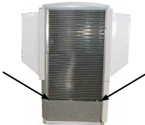
Über die beiden Revisionsöffnungen kann die Ausblasseite der Kondensatwanne auf Verschmutzung überprüft und ggf. gereinigt werden.
